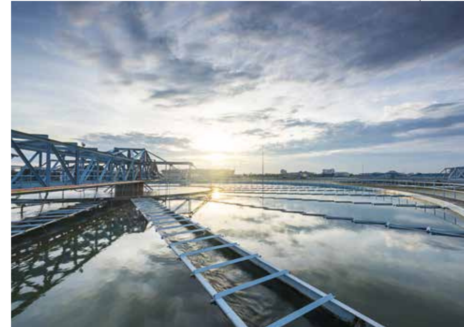
Egy víztisztító mű szilárd szennyeződést tisztító tartálya
